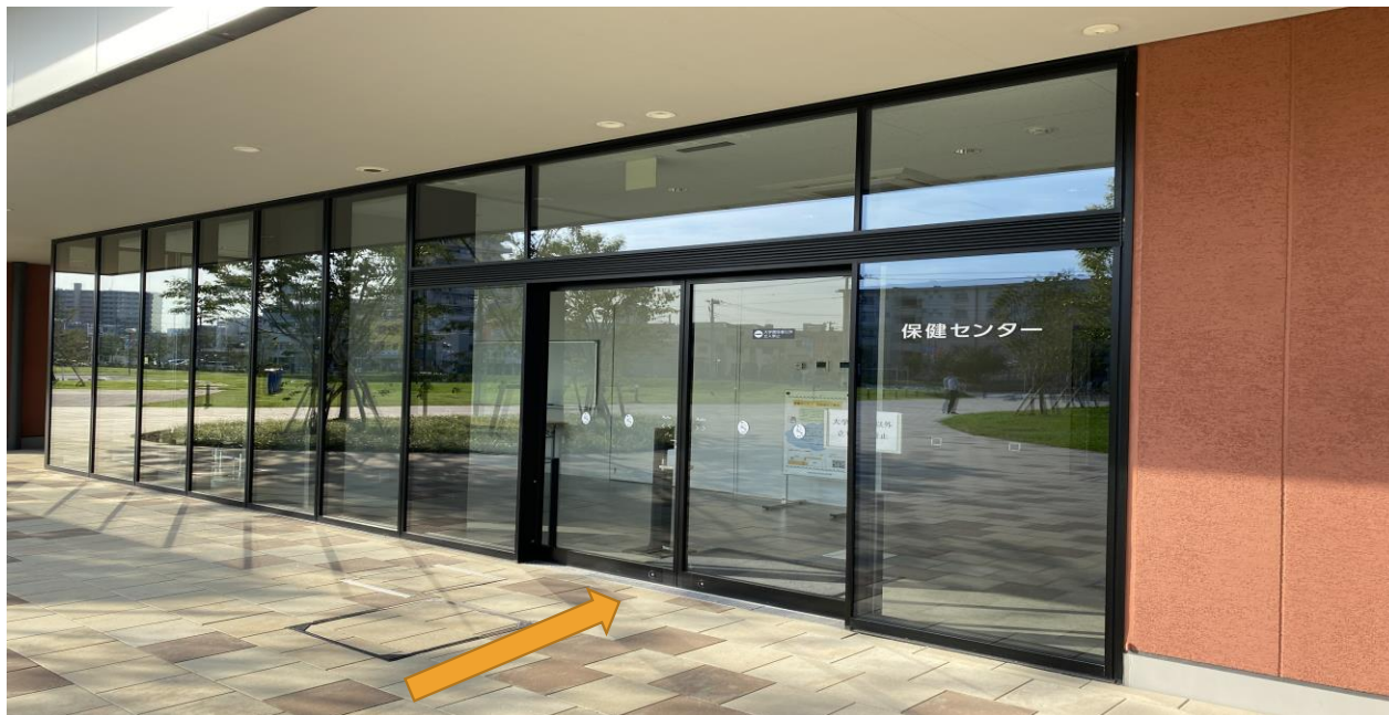
↑ 保健センター建物入口
